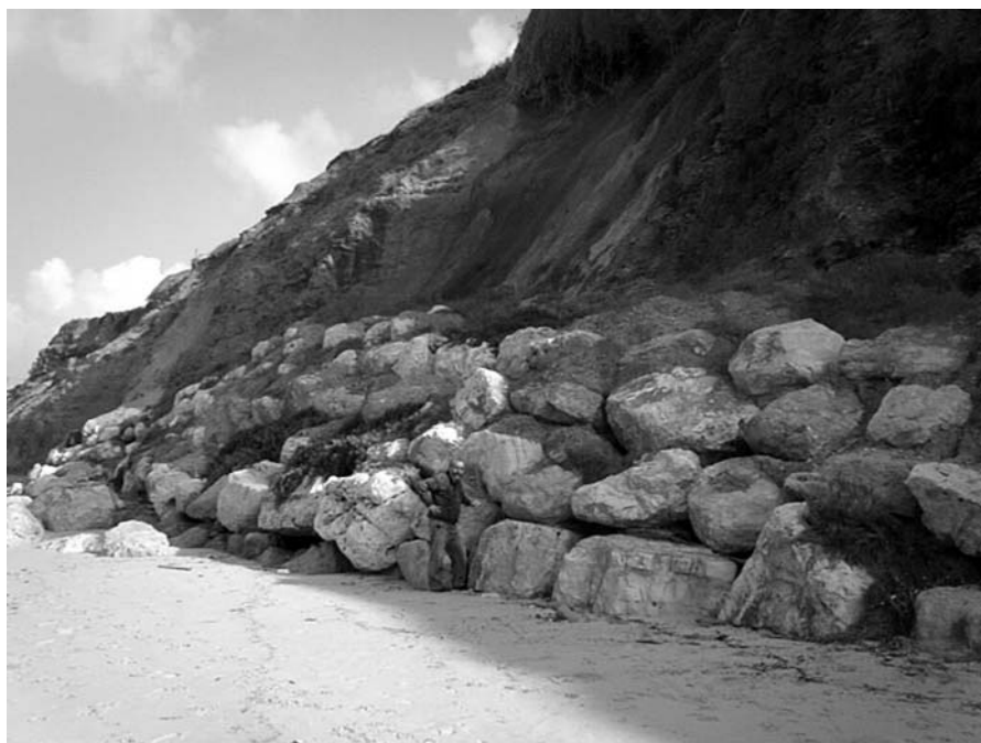
איור 9: הגנה מלאכותית בפני חתירת הגלים, לאורך חלק מבסיס צוק החוף בבית ינאי (11.12.2001)
