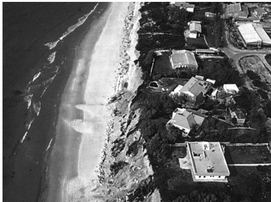
איור 5 : חלקו הדרומי והגבוה של צוק החוף בבית ינאי (מקור : פרת ואלמגור, 1996)
