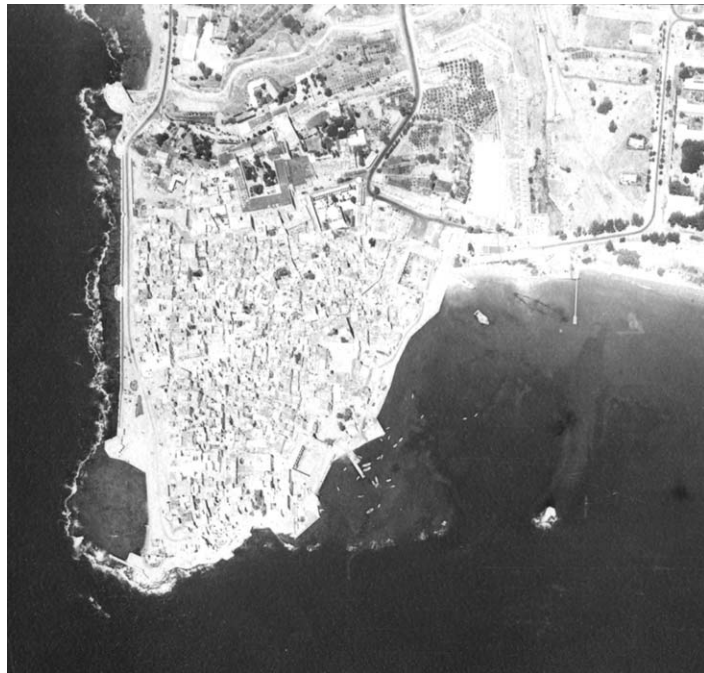
איור 15: תצלום אוויר של נמל עכו 26.08.1961, תמונה 4781, טיסה ממ/60 (המרכז למיפוי ישראל).
